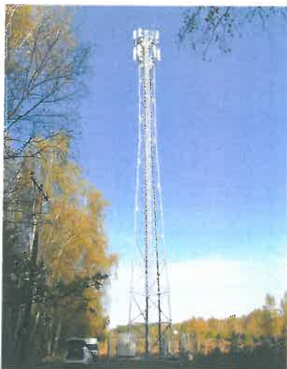
Fot. 1. 14417 WOŁOMIN GRANICZNA – widok wieży antenowej
